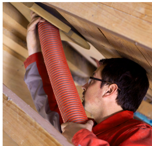
celulosa isofloc insuflada en cubiertas de madera
