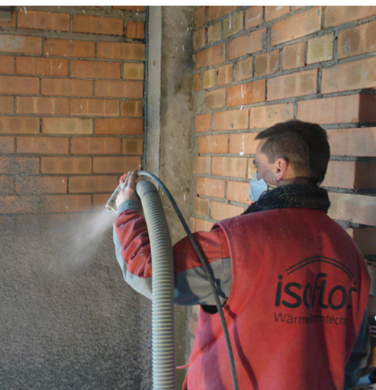
celulosa isofloc proyectada sobre pared y muros
